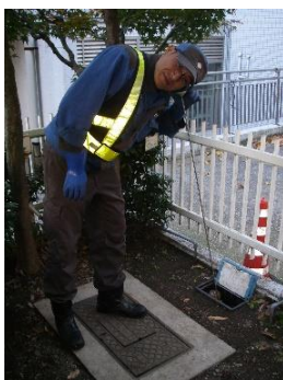
Leak Detection by a Leakage Sound Detection Bar 音聴棒による漏水調査
