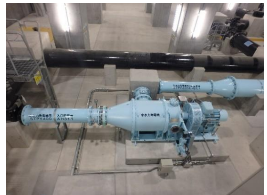
Small Hydraulic Power Generation (Kohoku Water Supply Station) 小水力発電設備（江北給水所）
